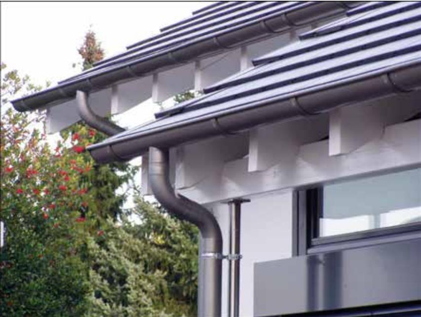
txn. Aufgrund seiner langen Lebensdauer von vielen Jahrzehnten wird Zink traditionell für Dachentwässerungssysteme eingesetzt. Das wartungsfreie Metall rostet nicht und entwickelt mit der Zeit eine schöne Patina, die sogar Kratzer wieder verschwinden lässt. txn-Foto: Initiative Zink
