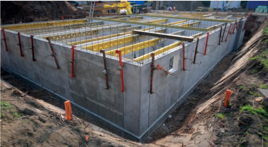
*txn. Damit die Grundmauer auf Dauer trocken bleibt, ist ein fachgerecht ausgeführtes Schutz- und Dränsystem unerlässlich.*
