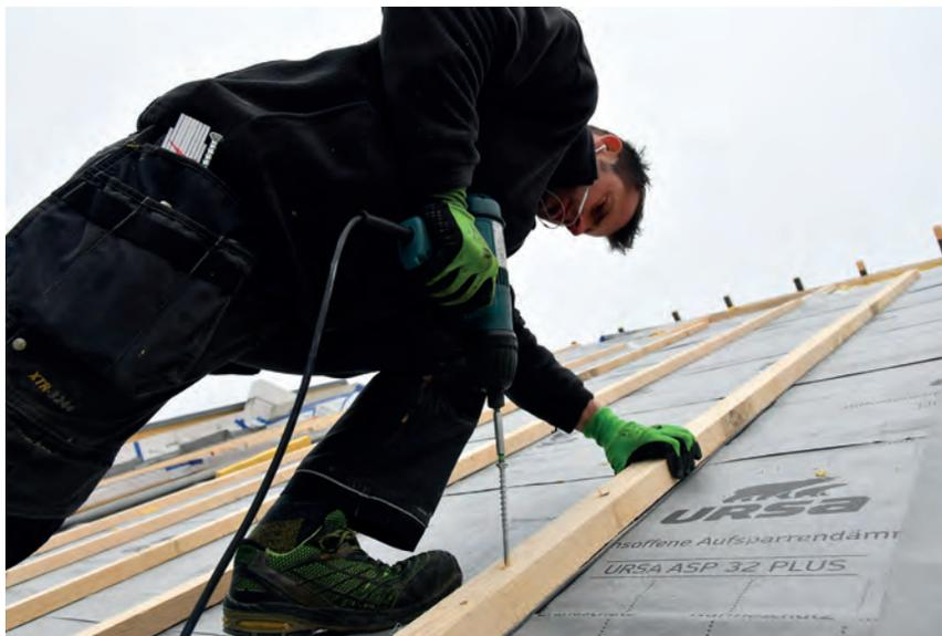
txn. Bei der energetischen Sanierung des Steildachs empfiehlt es sich, auf mineralische Dämmstoffe zu setzen. Im Sommer bleibt es unter dem Dach überraschend kühl, im Winter wird deutlich Energie gespart. Gleichzeitig verbessert Mineralwolle den Schall- und Brandschutz erheblich.
